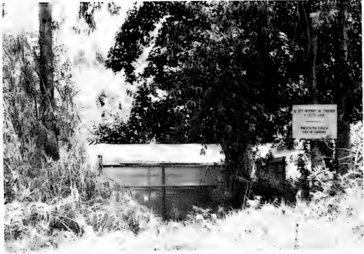
Abb. 3 Emergenzhaus am Kalengo. Außenansicht vom linken Ufer her.
